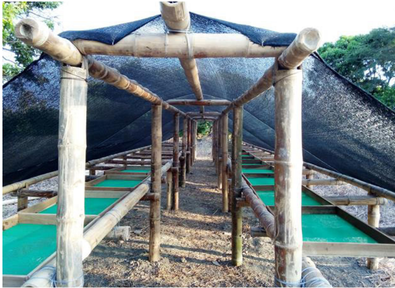
Foto 4.6. Sistema de secado combinado en mesones con zaranda y cubierta de sarán
